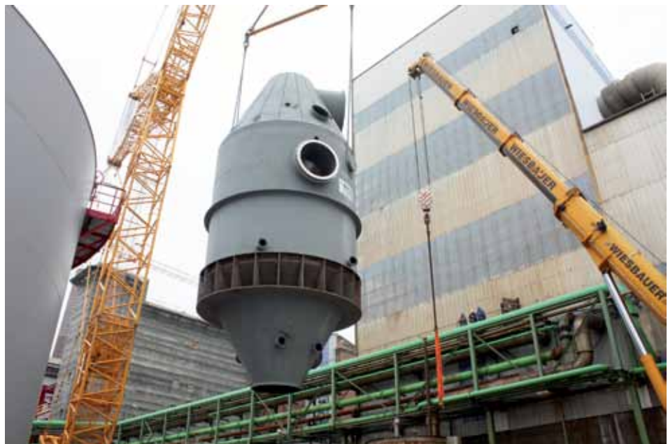
Einbau einer Eindampfanlage am Standort Wintershall zur Einbindung von Salzabwässern aus Unterbreizbach
