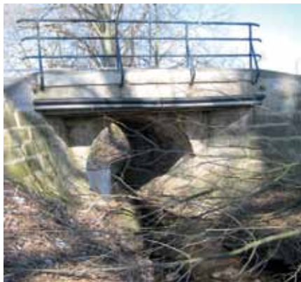
Salzbachbrücke - bestehend Querschnitt 2,5 m Dm.
