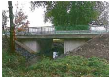
Salzbachbrücke - künftige Allerbrücke nach Querschnittsaufweitung 5,0 m
