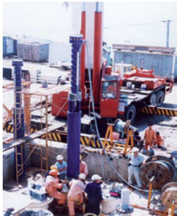
Abbildung 80: Beispiel nass aufgestellte Rohrpumpe
