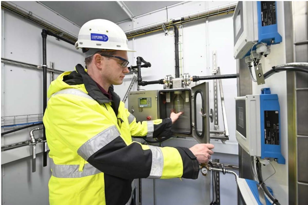
Abbildung 9: Neu entwickeltes Probennahmesystem
