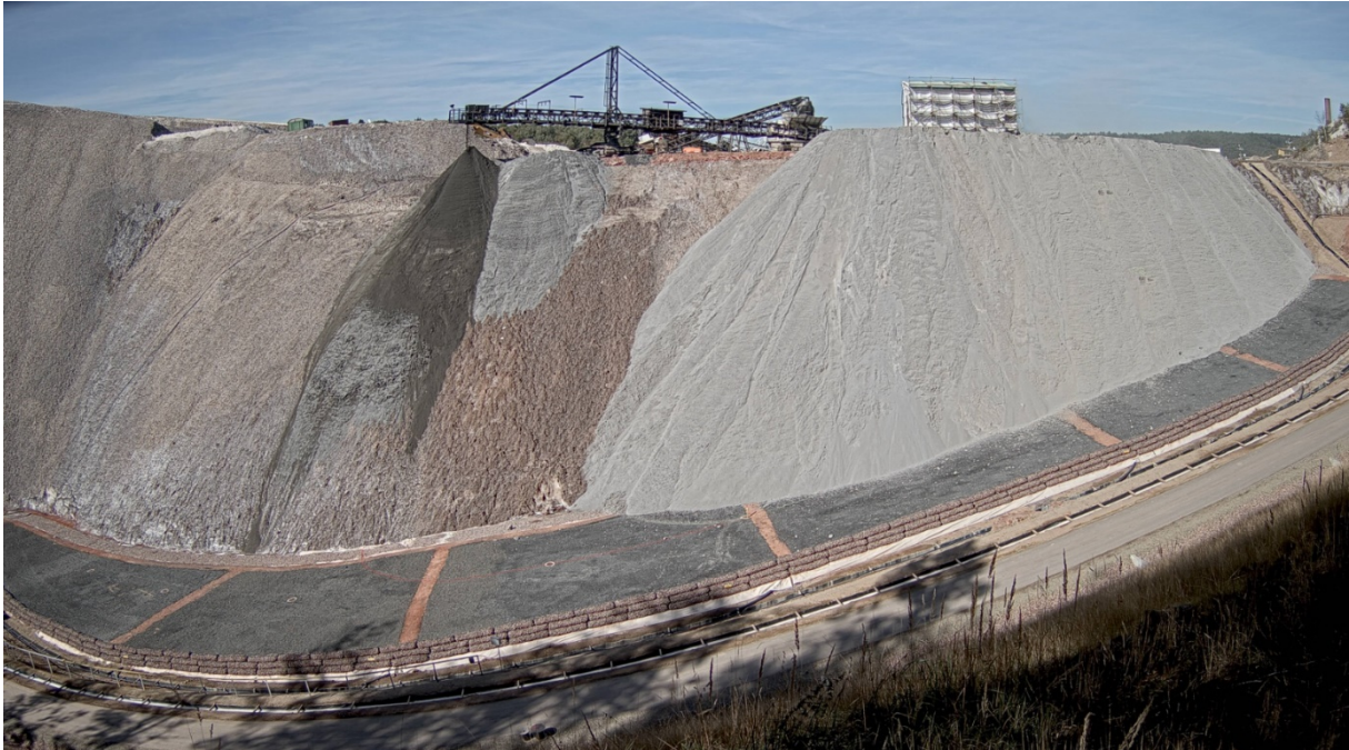
Abbildung 4: Durchführung der Flankenbeschüttung im Spätsommer/Herbst 2018- Halbtechnischer Versuch Hattorf
