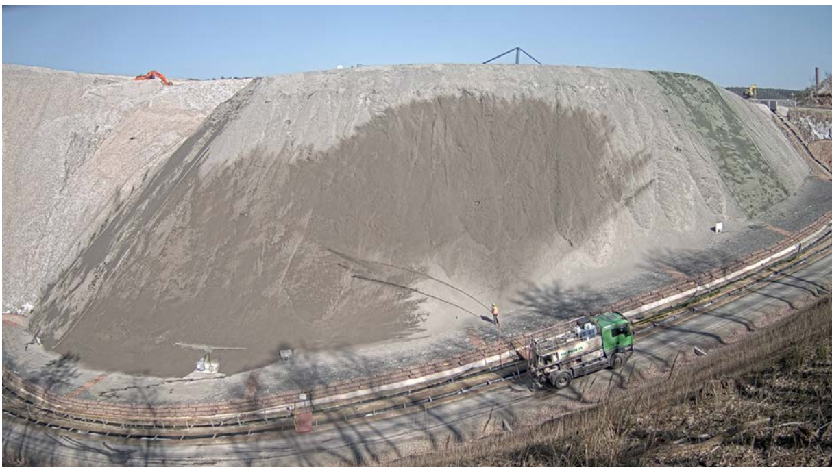
Abbildung 5: Nassansaat im Frühjahr 2019 – Halbtechnischer Versuch Hattorf
