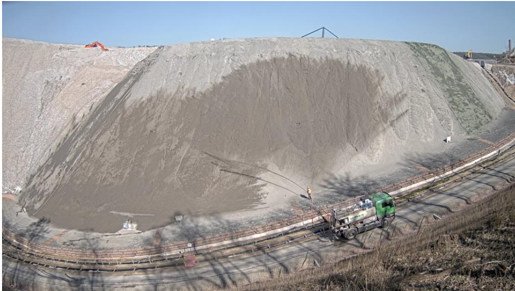
Abbildung 3: Nassansaat im Frühjahr 2019 – Halbtechnischer Versuch Hattorf
