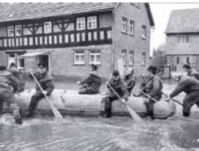
Hochwasser der Werra im März 1981, Feuerwehreinsatz in Breitung
