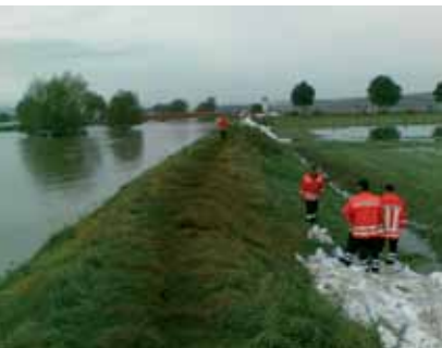
Deichsicherungsmaßnahmen vom Hochwasser vom Oktober 2007 an der Innerste bei Hildesheim
